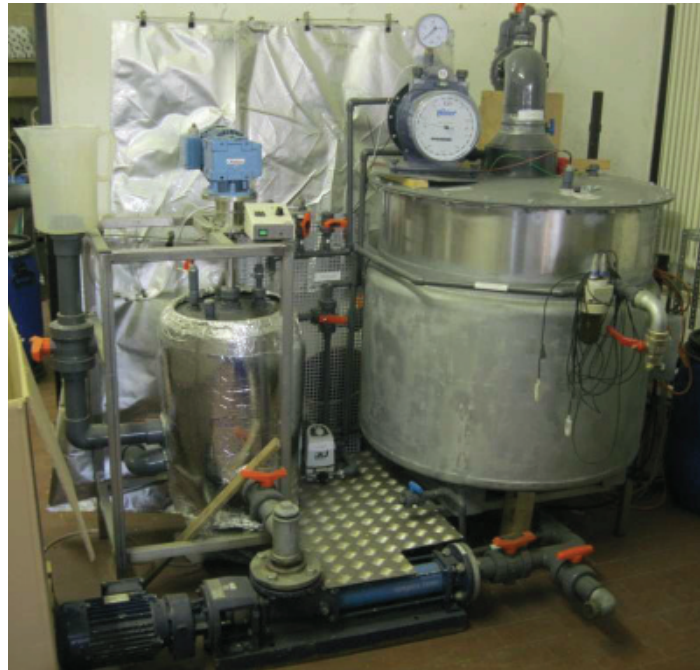
Abbildung 13: Zweistufige Biogasanlage mit kombiniertem Festbettreaktor im Technikum der HAWK (FG NEUTec)
