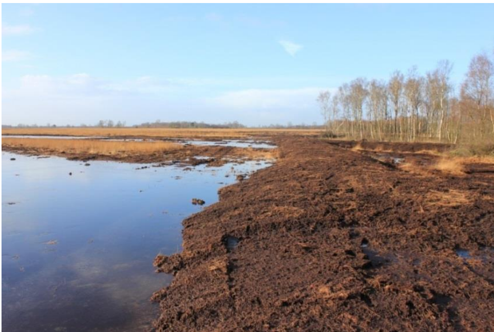
Abbildung 7: Anlage von Wällen zur Verbesserung des Wasserrückhalts im Mittleren Wie-tingsmoor (Landkreis Diepholz)
